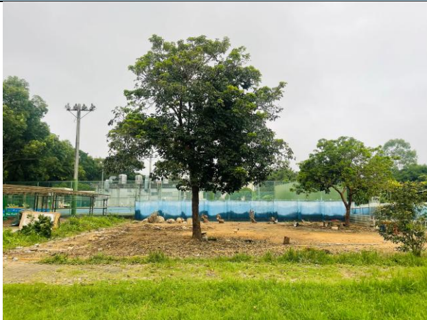
說明：FUN 羽村欄杆及鐵皮屋拆除。
