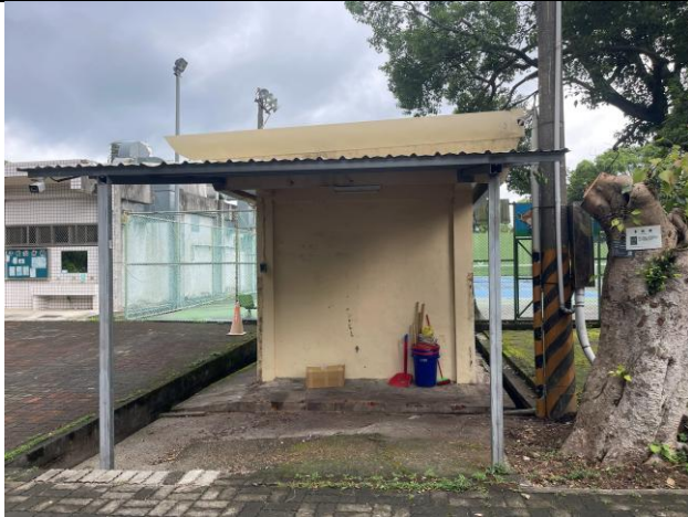
說明：外圍浪板拆除。
