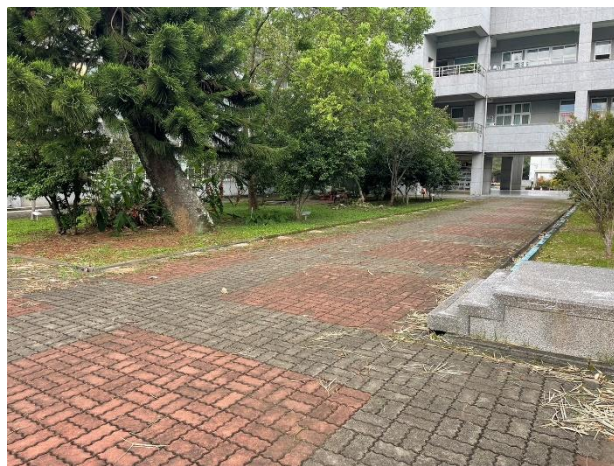
說明：水泥盆栽移除後
