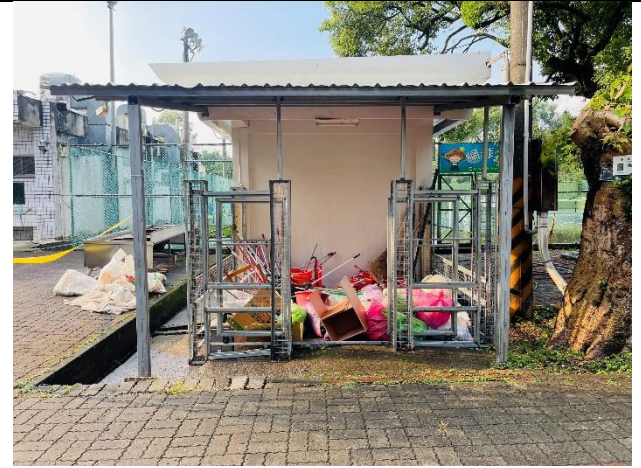
說明：鐵件支撐組裝。
